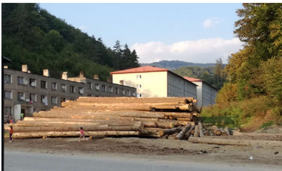
Obr. 3: Ukážka výstavby nových bytov v rómskej osade v Dobšinej (september 2018)
